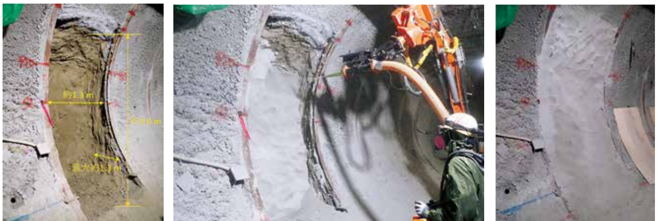
図 坑道の側壁に設けた切欠き部（左）、粘土材料の吹付けの様子（中）と吹付け完了時の様子（右）
